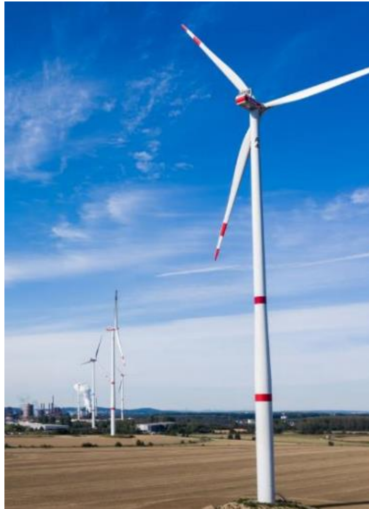
Energiepark Stahlwerk Salzgitter
