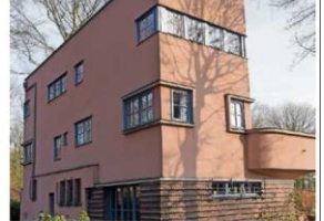
Haus Fischer ist eines der Gebäude in Wuppertal, die im Buch beschrieben werden. Foto: Gerhard Barsch
