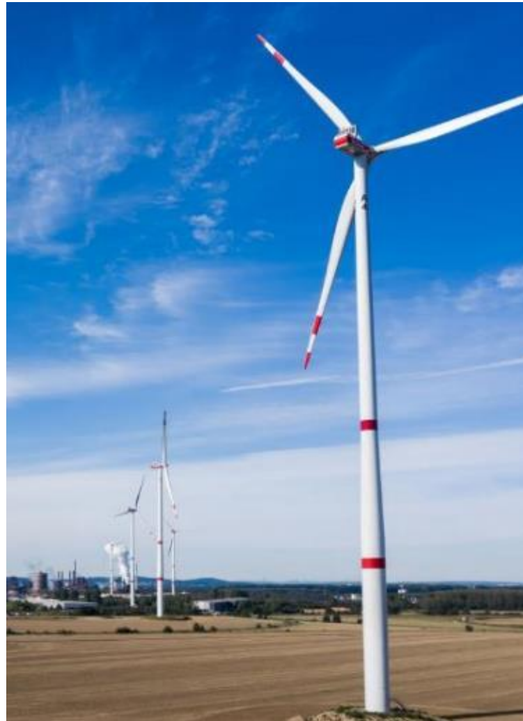
Energiepark Stahlwerk Salzgitter
