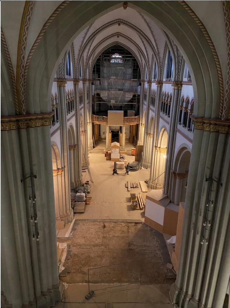
Maßnahmen im Inneren
