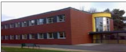
LVR-Louis-Braille-Schule, Förderschwerpunkt Sehen in Düren
