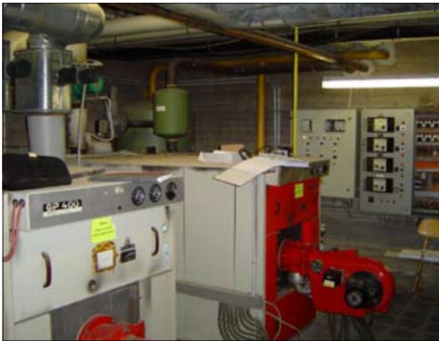
Demontage des vorhandenen Kessels (links)
