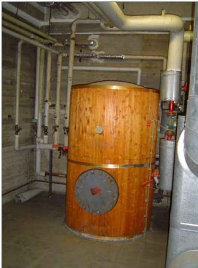
Austausch der zentralen Warmwasserbereitungen
