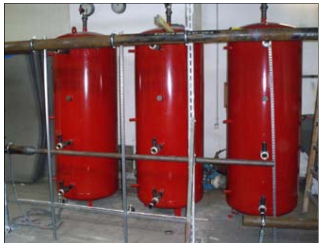
Aufstellen und Anschließen der neuen Pufferspeicher
