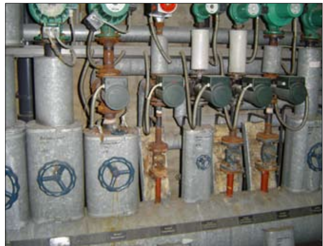
Demontage der Heizverteiler und Sammler
