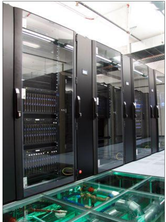
Sichtbarer Kälteanschluss der einzelnen Serverkühlleinheiten im HD Rechenzentrum
