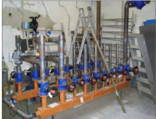
Gleichzeitig wird in der Heizzentrale der neue Heizkreisverteiler aufgebaut
