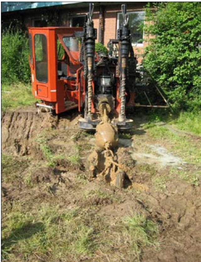
Mit Zurückholen des Bohrkopfes werden die Rohre in den Graben eingezogen
