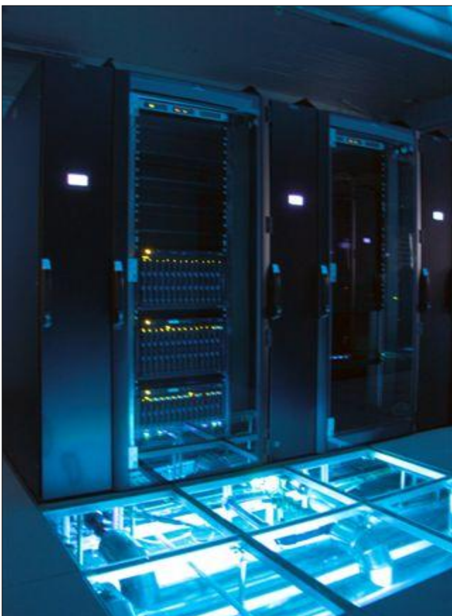
Sichtbarer Kälteanschluss der einzelnen Serverkühlleinheiten im HD Rechenzentrum
