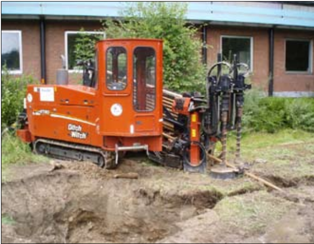
Bohrgerät für die Horizontal-Spülbohrung unter der Straße
