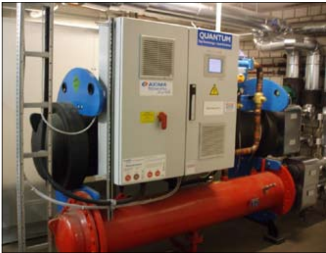
Ölfreier Turboverdichter Fabr. Axima; Typ: Quantum
