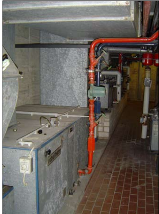
Ausbau der vorhandenen Zu- und Abluftgeräte der Schwimmbäder und Nebenräume
