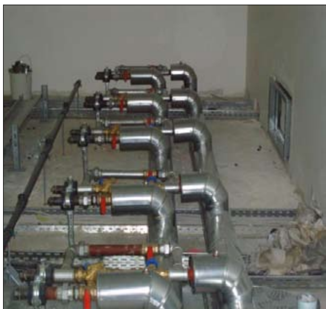
Kaltwasserinstallation im neuen HD-Rechenzentrum in der Bauphase
