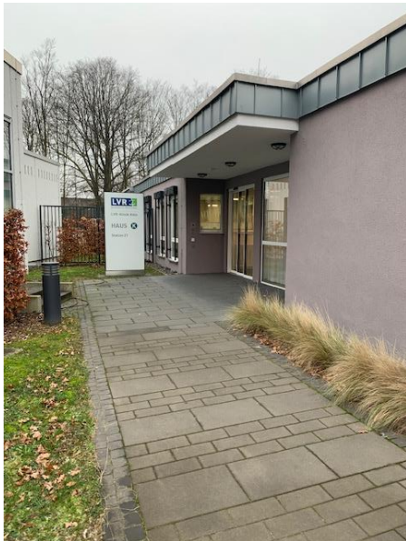
Abbildung 2: Eingangsbereich Gebäude K
