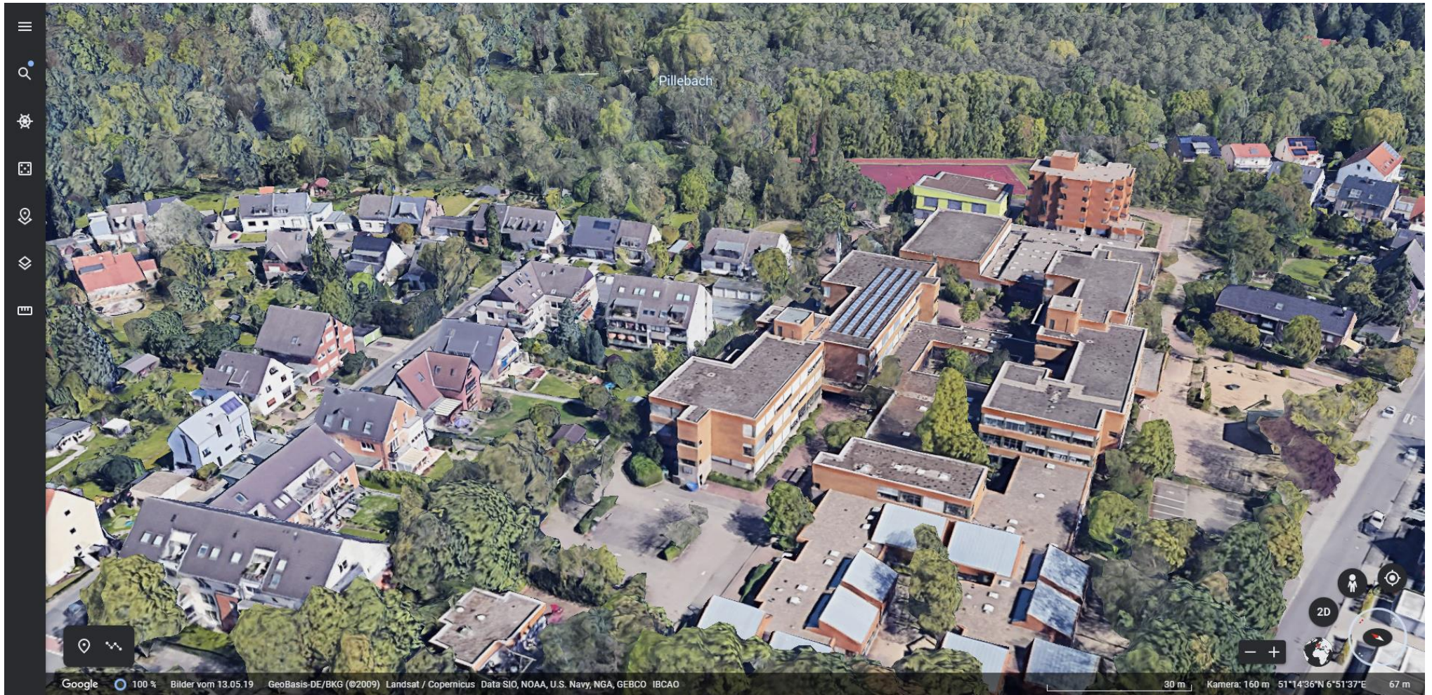
LVR Gerricuschule Westansicht
