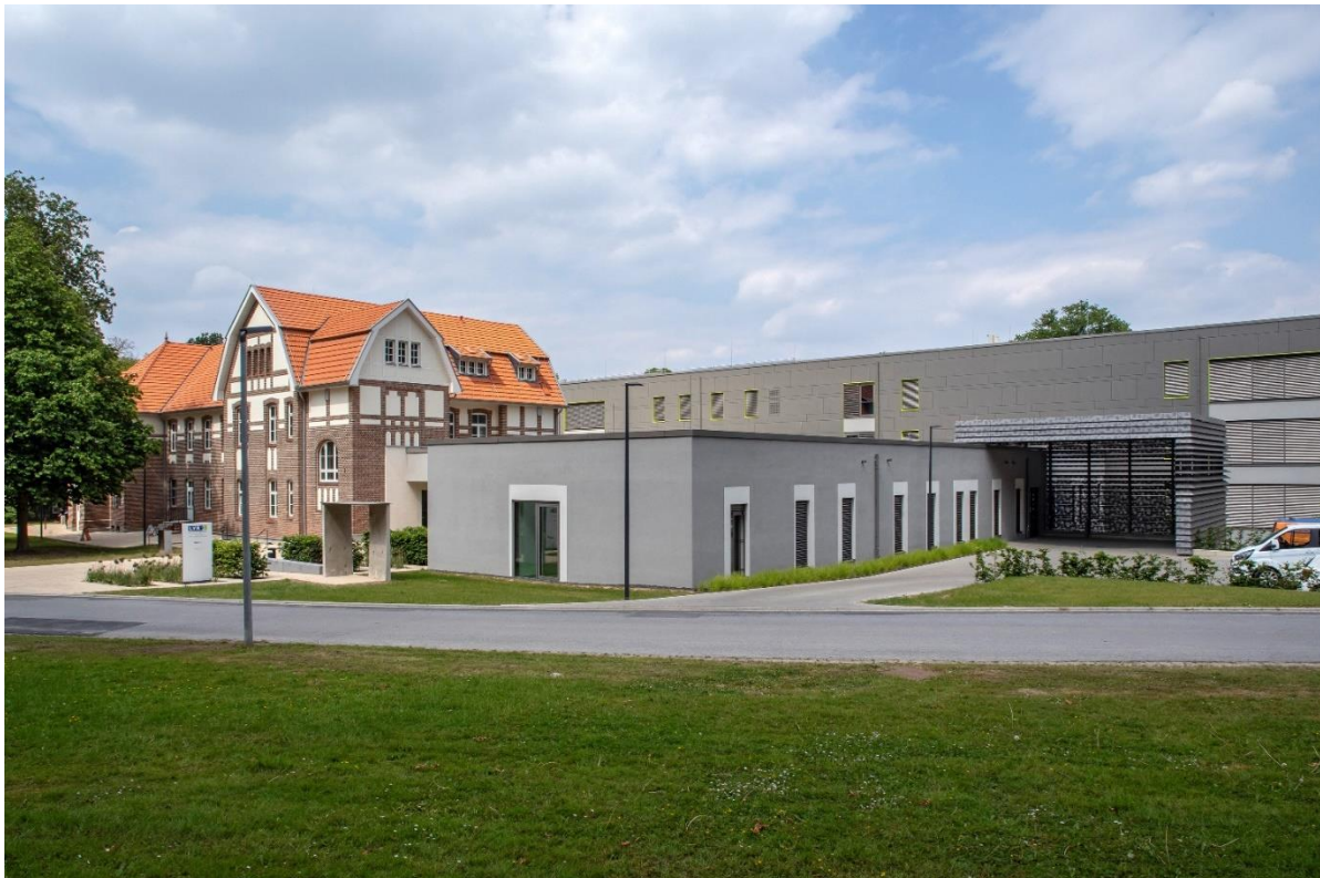
Bild 29 - LVR Klinikum Viersen, Neubau eines Stationsgebäudes
