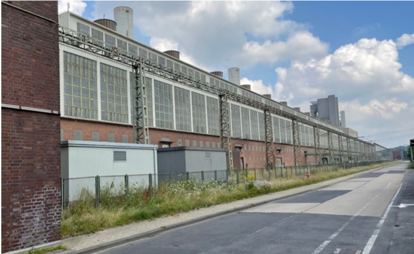
Zentraler Kraftwerksbau, Seitenansicht
