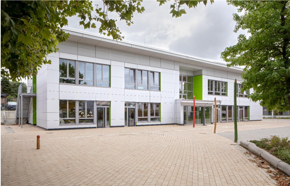
Bild 18 – Neubau OGS LVR-David-Bloch-Schule
