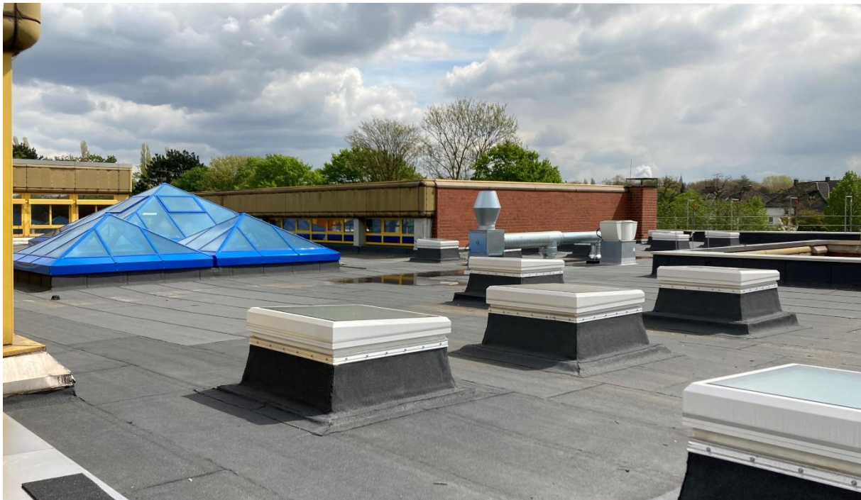
Bild 43 – Flachdachsanieierung der Christy-Brown-Schule in Duisburg mit neuen Lichtkegeln
