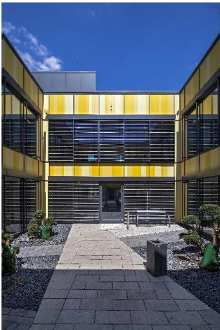
Bild 25 - Atrium „Lichthof“ Quelle: LVR-ZMB, A. Hiller
