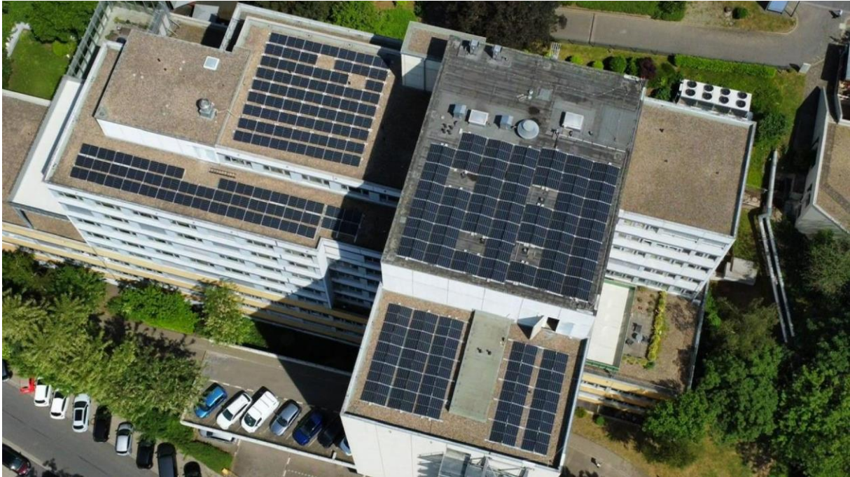
Bild 31 – Photovoltaik-Anlage des LVR Klinikums Essen
