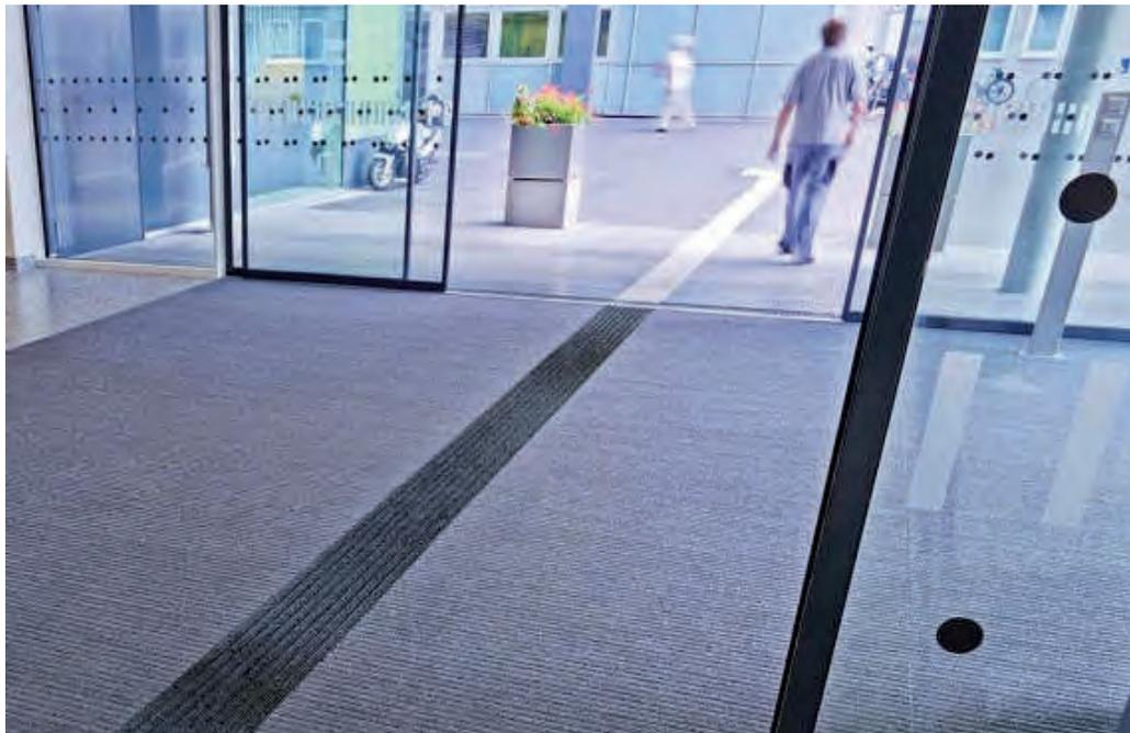
Fußmattensystem mit integriertem Blindenleitsystem um die Verbindung vom äußeren zu dem inneren Blinden - Leitsystem herzustellen.
