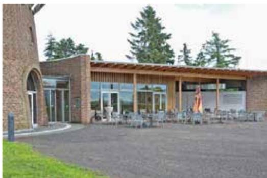
von Passivhaus-Komponenten geplant. Geheizt und gekühlt wird das Gebäude über eine elektrisch betriebene Sole-Wasser-Wärmepumpe. Das Dach ist extensiv begrünt und eine Photovoltaik-Anlage mit 4 kWp wurde montiert. Der gesamte Gastronomiebereich inklusive dem Erdgeschoss der Mühle bietet 76 Besuchern Platz.
