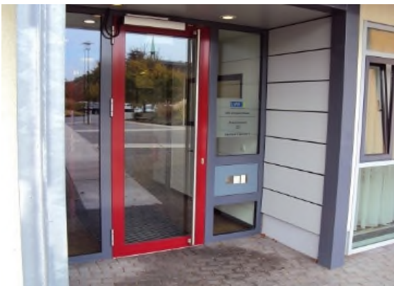
Abbildung 3: Eingang Tagesklinik Wickenburg (außen)
