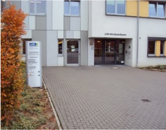
Abbildung 1: Eingang Wickenburg (außen)
