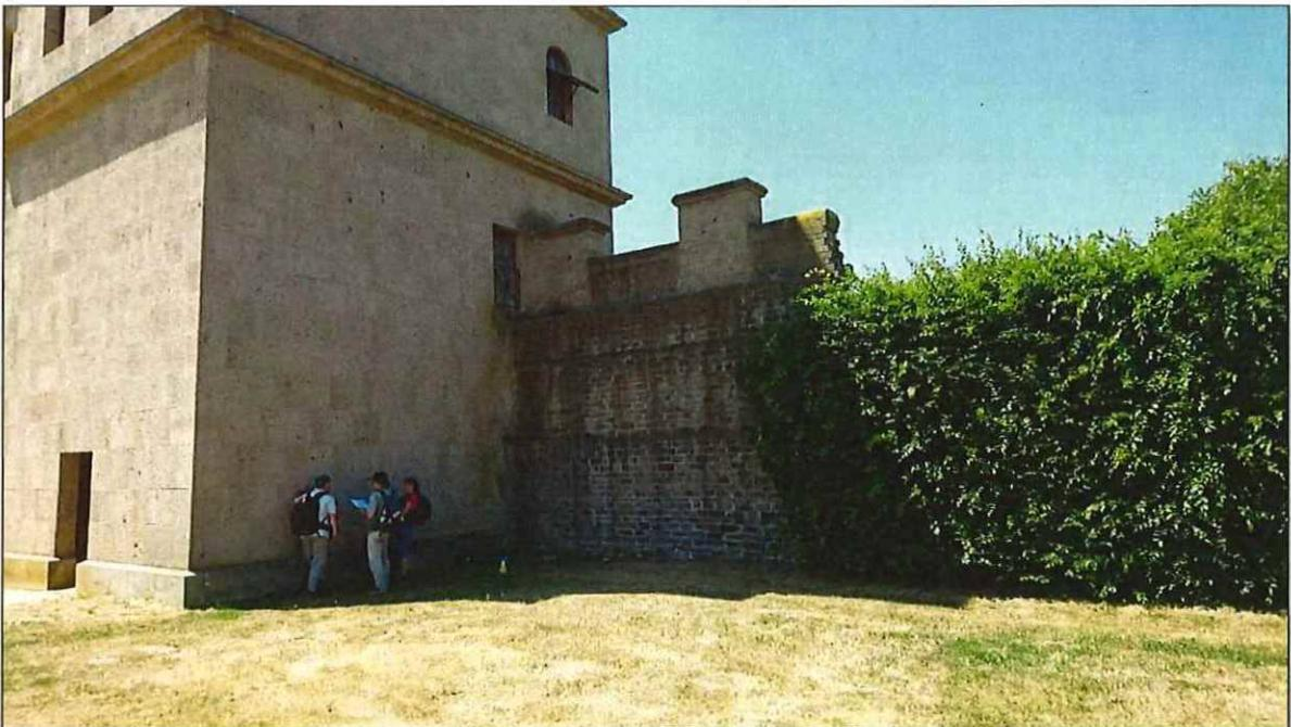
Abb. 21: Die nach Nordosten ausgerichtete Gebäudemauer des Nordtors (Burginatiumtor) weist aufgrund der Schattenlage eine höhere Feuchtigkeit auf (Foto: P. Keil, 2018).
