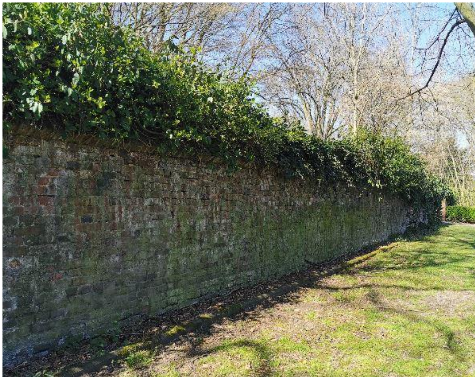
Foto: Abtei Brauweiler – östliche Stützmauer ( Bildnachweis: Büro Hutt )
