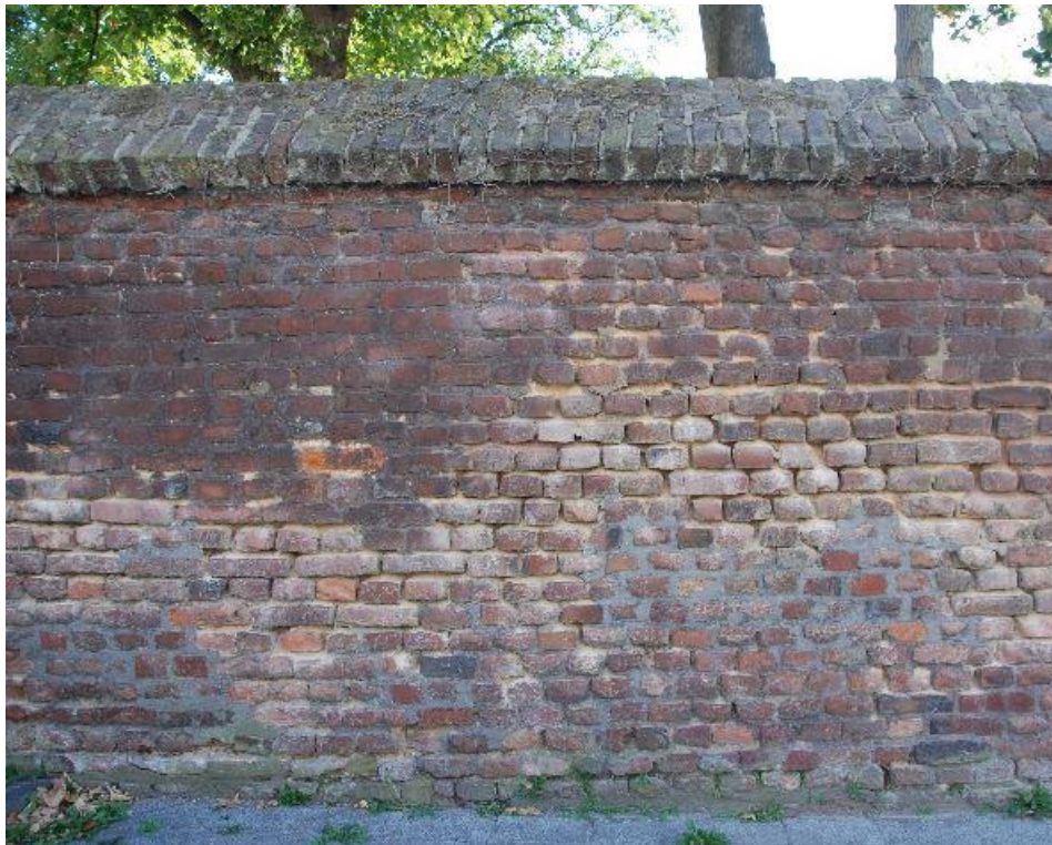
Foto: Abtei Brauweiler – westliche Stützmauer ( Bildnachweis: Büro Hutt )
