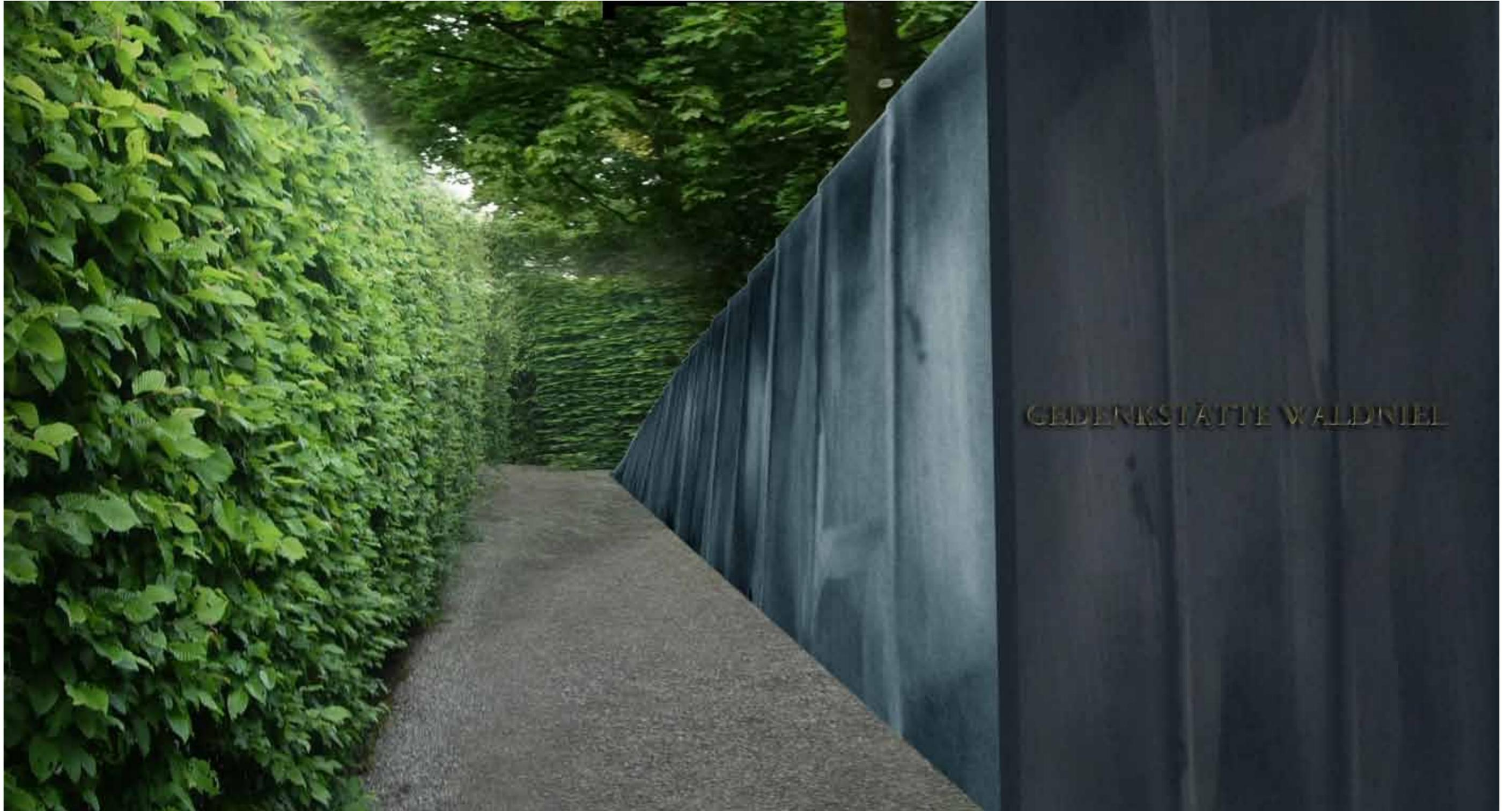
An der Längsseite ermöglicht die Skulptur den Hereingehenden eine langsame Annäherung, die durch das allmähliche Neigen der Betonelemente erzeugt wird. Über 36 m verschieben sich die Elemente um jeweils zwei Grad, bis sie schließlich horizontal am Boden liegen und so den Blick und Weg in die Gedenkstätte freigeben.
