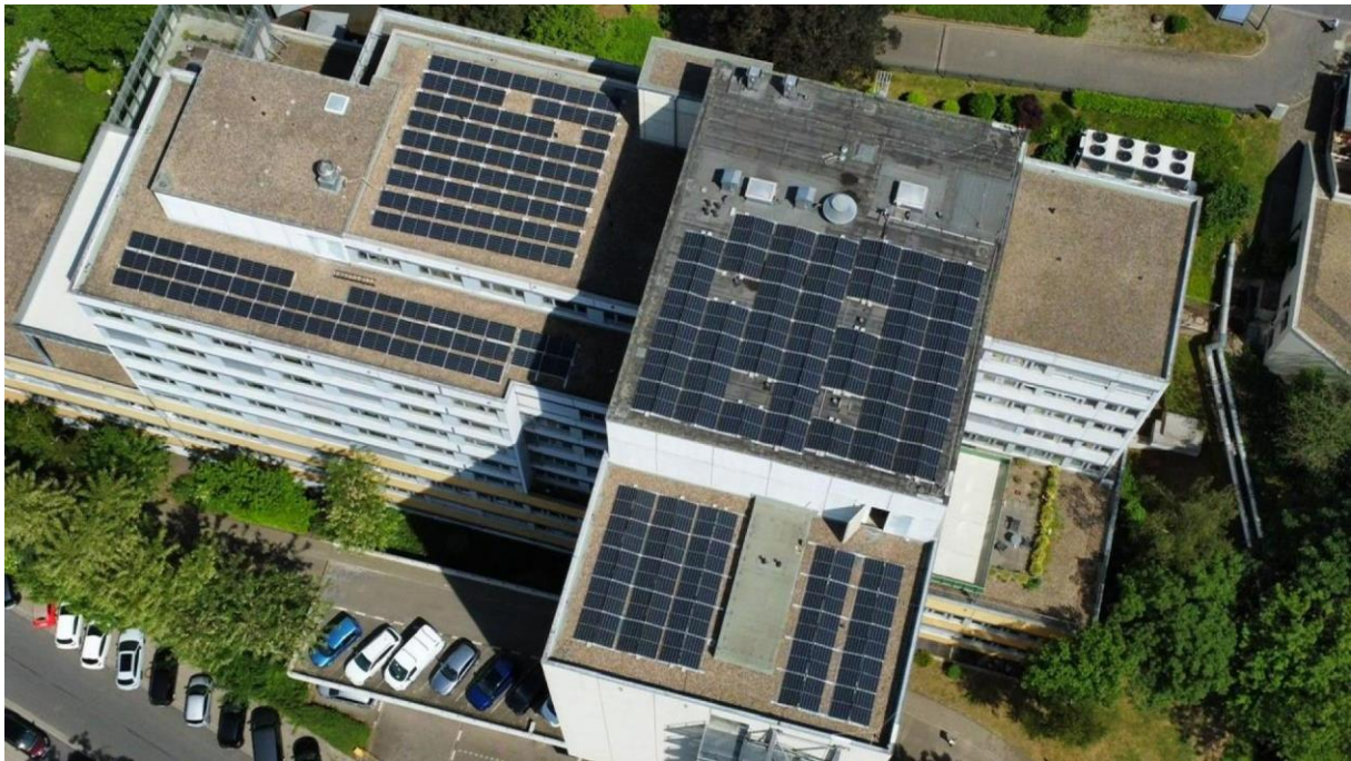
Bild 31 – Photovoltaik-Anlage des LVR Klinikums Essen
